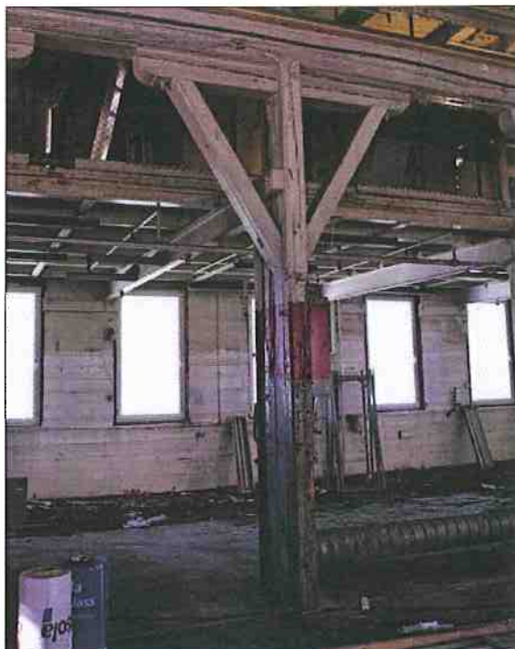
BALKONG: Solide y-søyler holder oppe konstruksjonen midt i 1. etasje. Ovenfor og bak søylene skimtes balkongen som skal lukkes med vegg og inneholde øvingsrom og oppholdsrom.
