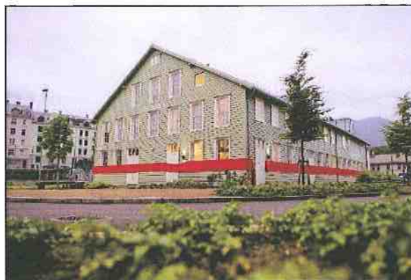
Det nye teateret på Marineholmen var kledd i rødt bånd for anledningen. Foto: VIDAR LANGE LAND
