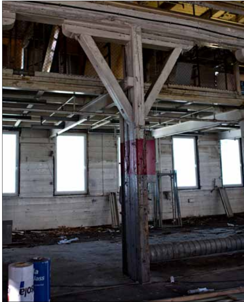
BALKONG: Solide y-søyler holder opp konstruksjonen midt i 1. etasje. Ovenfor og bak søylene skimtes balkongen som skal lukkes med vegg og inneholde øvingsrom og oppholdsrom.
